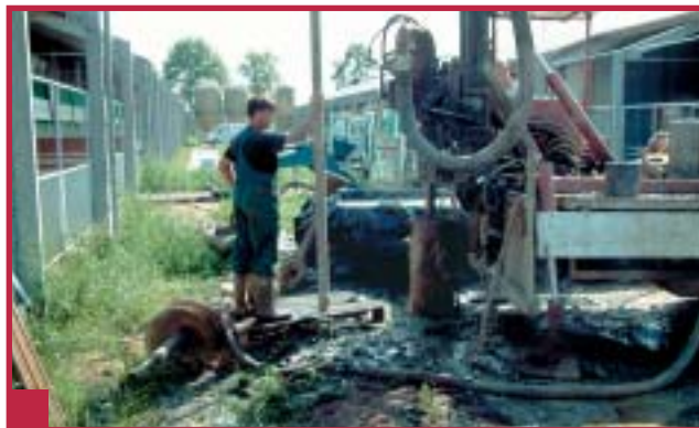
Anleg van bodemcollectoren via een gesloten leidingstelsel.
